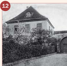
12 Kath. Schulhaus (von Wallbrunn) 17. Jhd.
